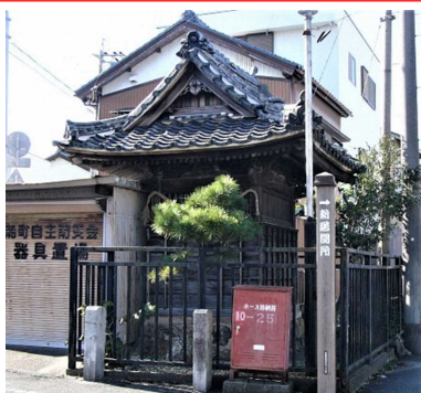
ふなまち さやどう ④⑱船町の鞘堂 湖西市新居町新居
