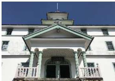
残存する最古の洋風校舎 「旧見付学校」 (磐田市)
