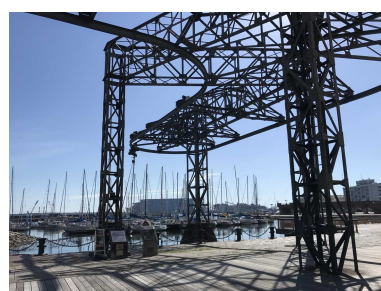
清水港テルファー《国登録有形文化財》 集荷した木材を積み込む鉄道施設
