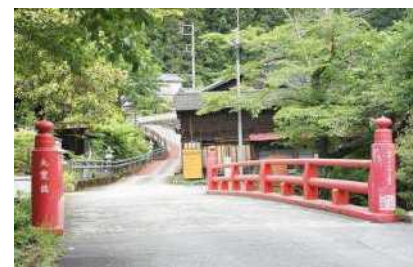
坂下宿の九里橋（浜松市）
