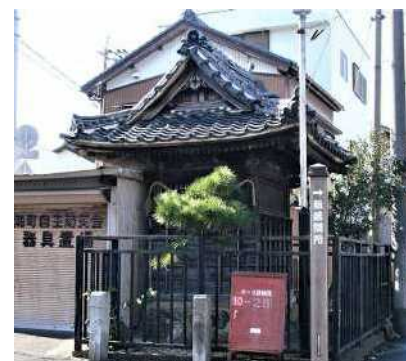
船町の鞘堂（湖西市）
